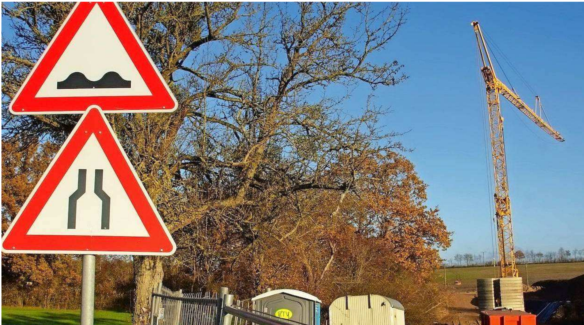
Erster Bauabschnitt Nord-Ost-Tangente: Begonnen wird mit dem Bau einer Brücke über die Bahngleise in Höhe der Kleingartensiedlung. Foto: Uwe Hentschel
