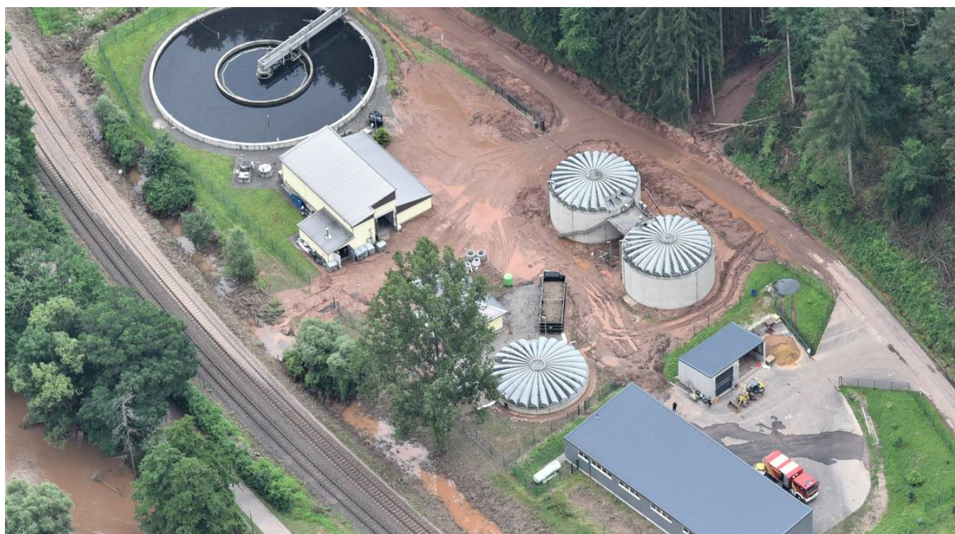
Das Klärwerk in Kordel nach dem Hochwasser. Foto: Portaflug
