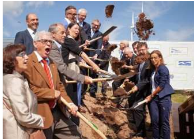
Jetzt geht's los: Die Projektbeteiligten feiern den Spatenstich für das Regionale Verbundprojekt der Landwerke Eifel in Plütscheid
