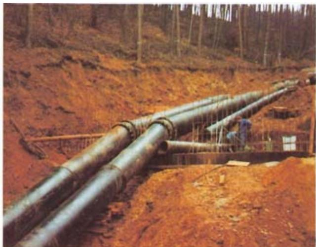
Bild 6: Zu- und Ablaufleitungen DN 800 zum Hochbehälter bzw. zur Aufbereitungsanlage
