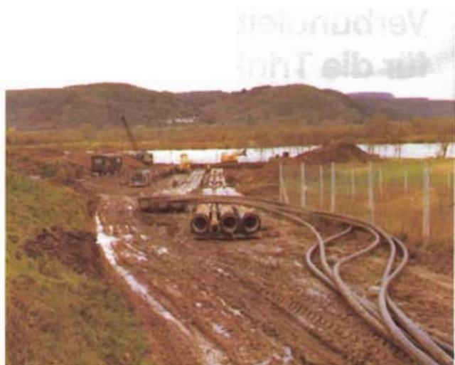
Bild 5: Der Strang links wird zuerst eingezogen, der Strang rechts später angeflanscht und mitgezogen
