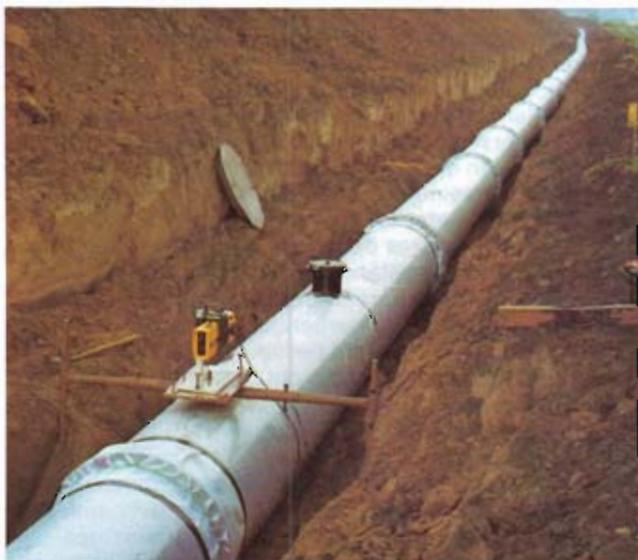
Bild 4: Verlegung der duktilen Gußrohre mit Laser-Gerät
