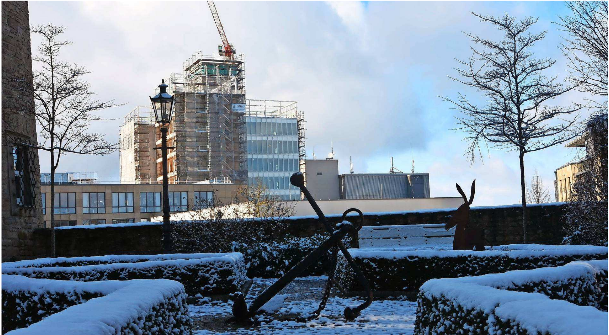
Die Arbeiten am Brauereiturm in Bitburg gehen gut voran. Foto: Christian Altmayer Foto: TV/Christian Altmayer
