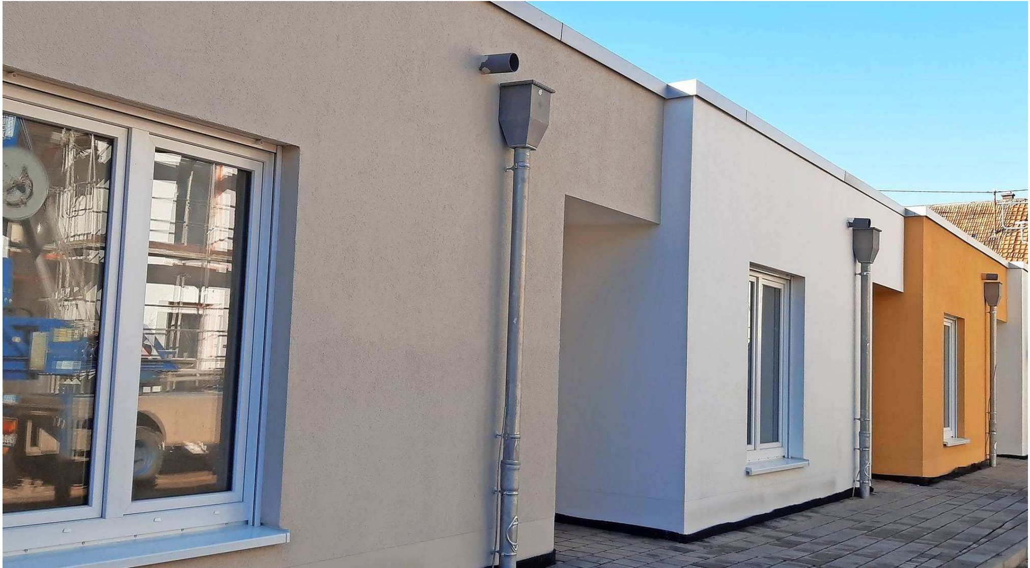
Zwar sind Bungalows und Appartements noch nicht bezugsfertig, aber schon zu mieten. Foto: TV/Schwesternverband
